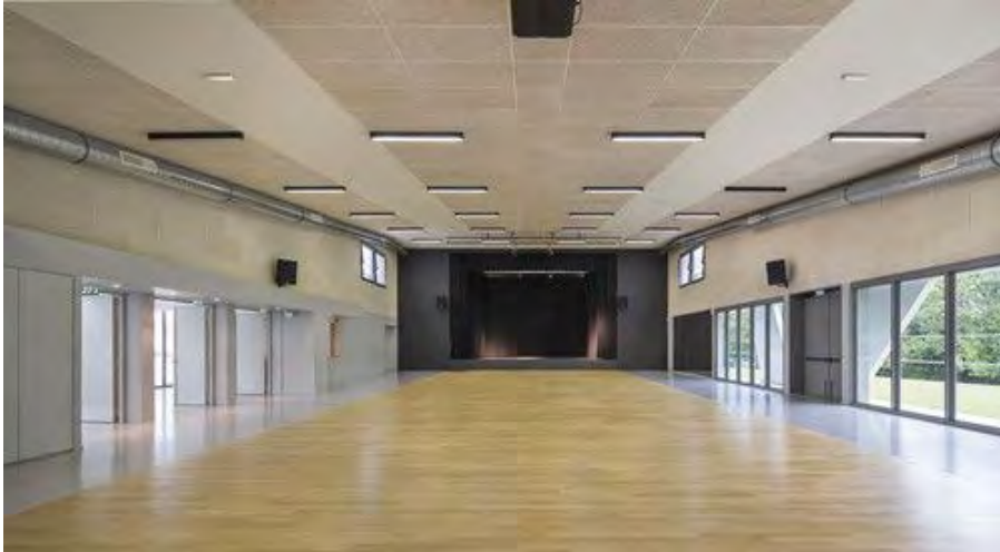
Salle d'activité modulable Espace polyvalent / jeux de plafonds acoustiques (bois / dalles minérales blanches ou noires) / cloison amovible / placards intégrés / ensemble architecturaux entrées- placards / sols souples acoustiques
