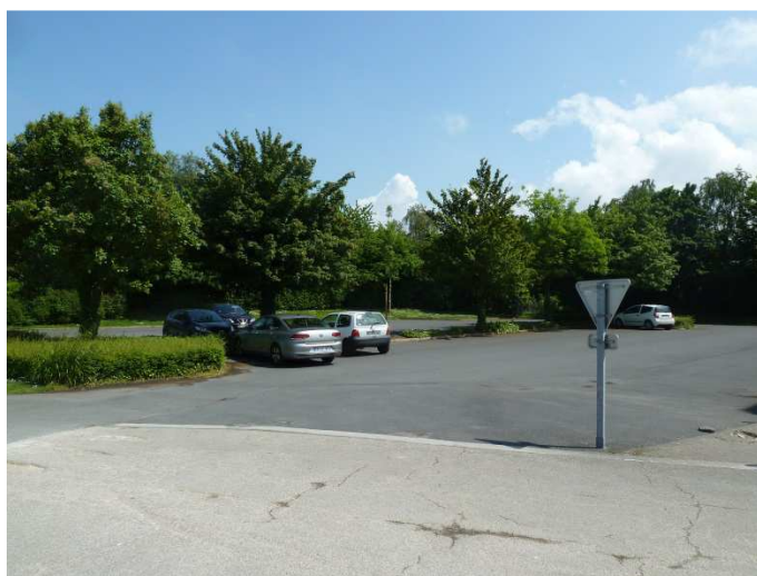
2 - Vue d'ensemble du parking
