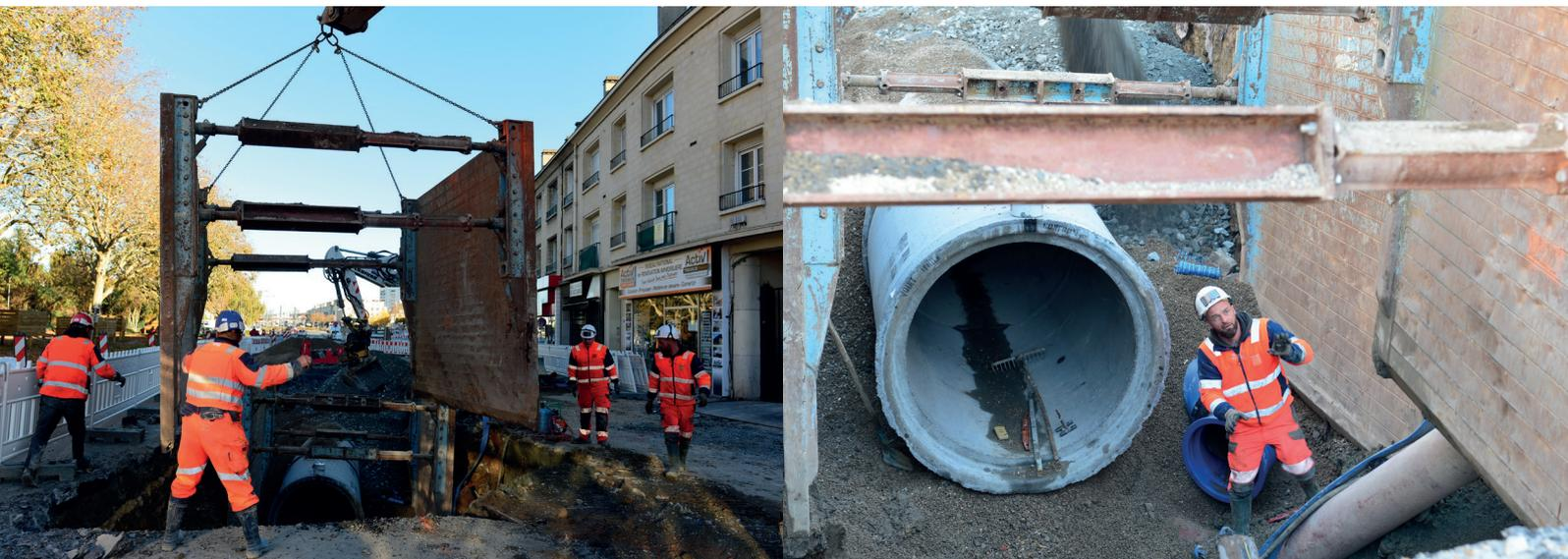
Mise en place de blindage de tranchée. Maintien des terres et protection des ouvriers dans la tranchée.
