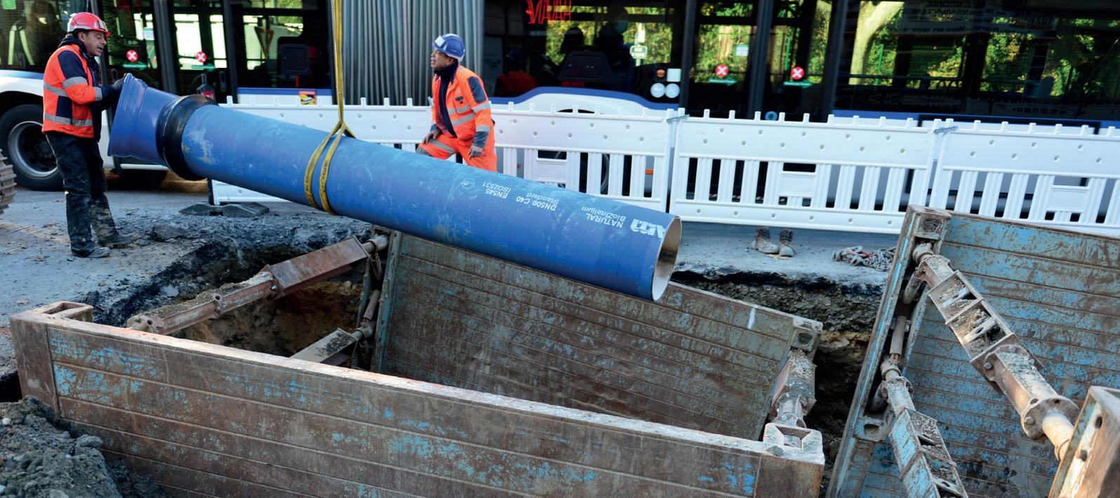
Approche d'un tronçon de canalisation d'eau potable en fonte de 500 mm de diamètre
