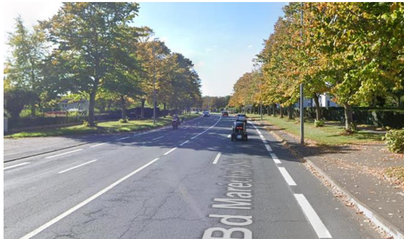
Bandes cyclables sur le Boulevard du Maréchal Juin
