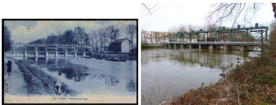
Vues sur le barrage de Montalivet (1908-2016)
