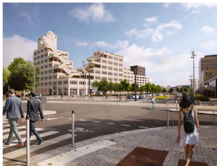
Vue depuis le carrefour rue Rosa Parks / cour Montalivet
