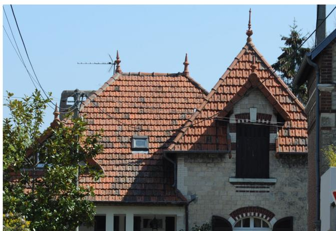
**Couverture en tuiles mécaniques sur un pavillon «Entre-deux-guerres».**
