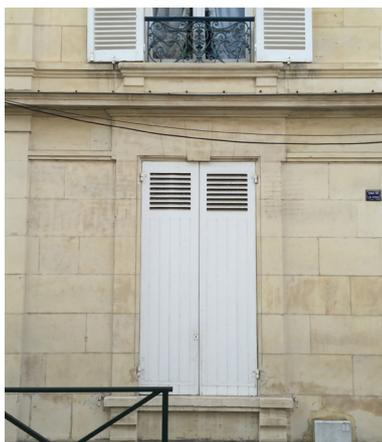
Volets battants semi-persienés au rez-de-chaussée et persienés aux étages.
