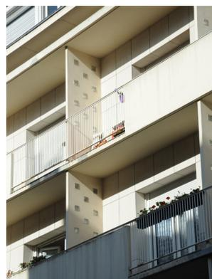
Séparatif de balcon en béton avec incorporation de pavés de verre.
