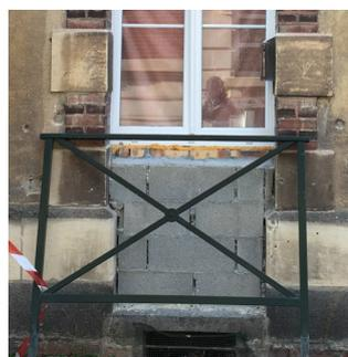
● Photo de gauche bouchement d'allège en cours de travaux, photo de droite, travaux terminés (fenêtre de gauche) : l'appui de fenêtre a été simplifié > absence de mouluration et de leur retournement vers la façade.
