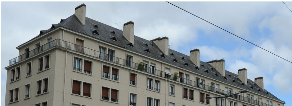
Toiture sans lucarnes ni chassis de toit, rythmée par de petites ouvertures de ventilation et par les cheminées.
