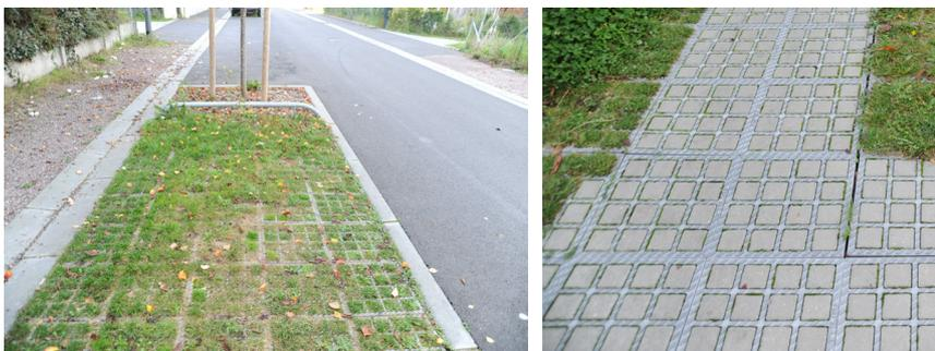
Exemple de matériau drainant végétalisé pour des surfaces de stationnements.
