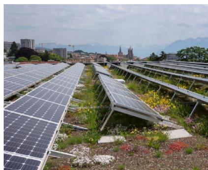
la végétalisation des toitures terrasse augmente le rendement énergétique des panneaux solaires en rafraîchissant l'arrière des panneaux par leur évaporation et réduit les pertes de rendement énergétique en évitant la surchauffe.
