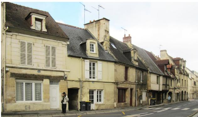
Série de maisons de même forme, mais de mode constructif différent : rez-de chaussée et étage en maçonnerie ou étage en encorbellement en pan de bois, 112 à 122 rue Caponière.
