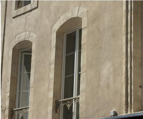
Enduit tyrolien, non cohérent avec le type de bâti, de style Classique. Il peut être conservé et ravalé, ou remplacé par une finition adaptée à la constitution de la maçonnerie.
