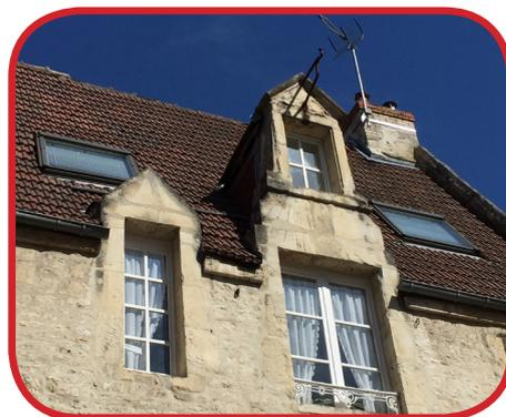
● Fenêtres de toit trop larges et mal positionnées.
