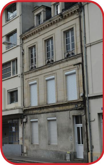
● Façade en pierre de Caen, de style Classique, altérée par des travaux inappropriés (enduit ciment, volets roulants).
