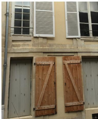
● Les volets à barre en écharpe (Z) et les volets en PVC sont proscrits.
