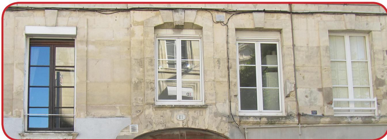
● Exemple ci-dessus : quatre fenêtres d'une même façade traitées différemment ; à proscrire : volets roulants, matériau non d'origine, petits bois inclus dans le vitrage, couleur non homogène, garde-corps non cohérents avec le style de bâti.
