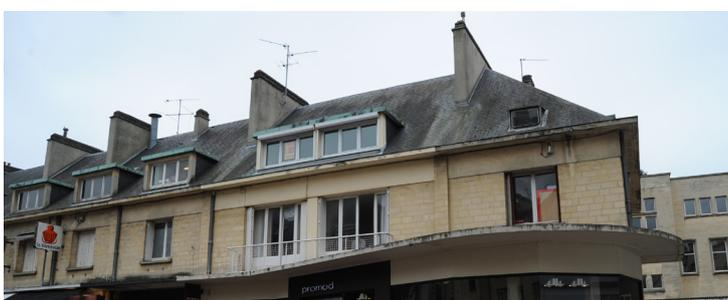
Toiture avec de grandes lucarnes d'origine, couvertes en cuivre.
