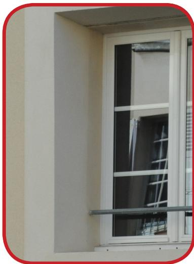
**La règle :** la nouvelle fenêtre doit être posée à l'emplacement de la fenêtre d'origine dans la baie.
