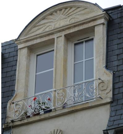
● **Vitrage** : les profils intercalaires du double-vitrage ne doivent pas être brillants.
