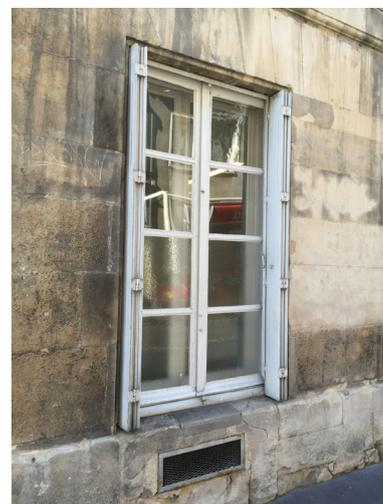
Fenêtres, doubles fenêtres : ci-dessus, à peine perceptible depuis l'extérieur, une deuxième fenêtre permet de conserver la fenêtre d'origine (très efficace pour l'isolation phonique ou pour isoler des fenêtres d'un dessin complexe) .
