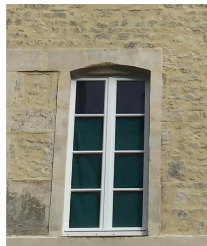
Maçonnerie de pierre de taille et moellons à joints beurrés\*, très courante.
