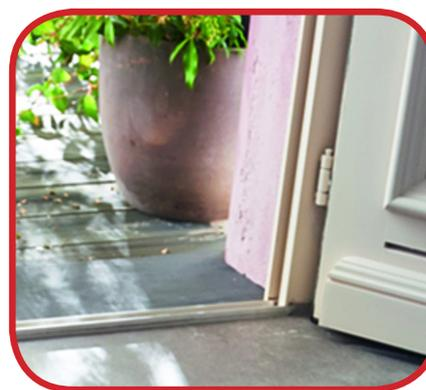
● **Ci-dessus** : seuil d'étanchéité standard en aluminium, d'aspect trop industriel et qui se détériore rapidement.
