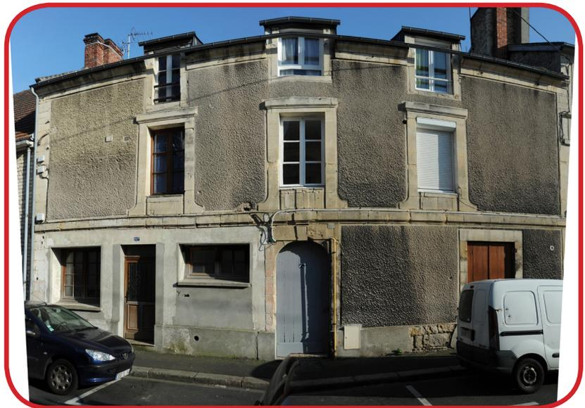
● Rez-de-chaussée altéré par des modifications de percements inappropriées, réalisées sans respect de la composition de la façade, et avec une finition grossière avec un enduit ciment inadapté à la maçonnerie de pierre.
