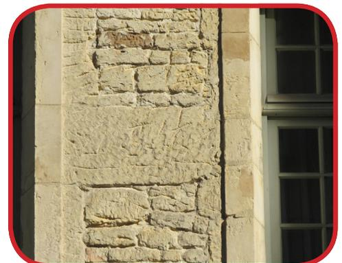
● Les griffures sur la maçonnerie de moellons montrent qu'elle était recouverte d'un enduit ; il doit être refait.
