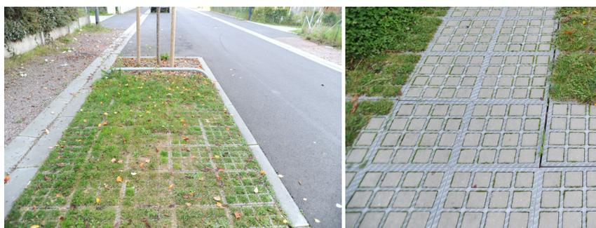
Exemple de matériau drainant végétalisé pour des surfaces de stationnements.
