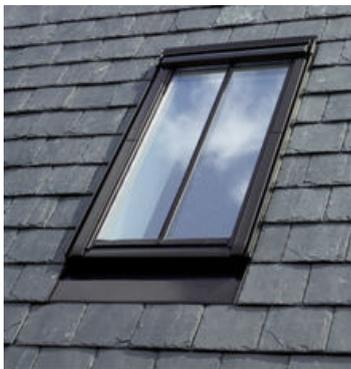
Modèle encastré (ne dépassant pas de la surface de la toiture) avec meneau divisant les carreaux verticalement.
