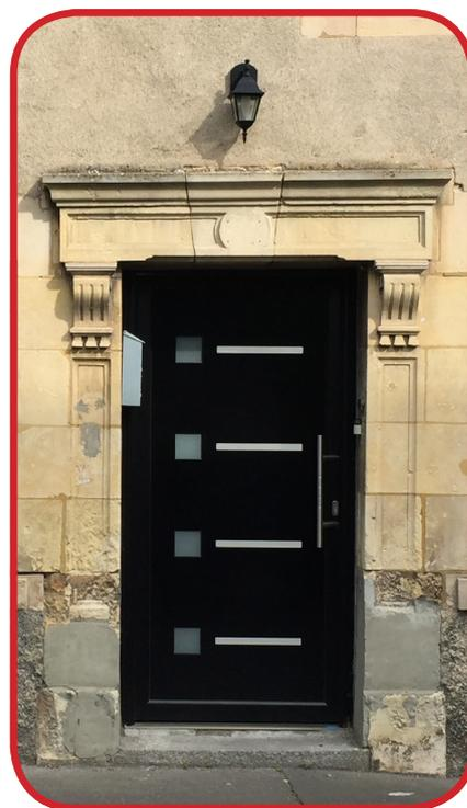
● **Porte d'entrée** : les portes de fabrication industrielle ne sont pas adaptées au bâti ancien.
