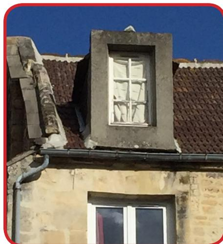
● Exemple de lucarne totalement altérée par des travaux inappropriés. A noter : avec la tuile plate remplacée par une tuile mécanique, c'est toute la toiture qui est altérée.
