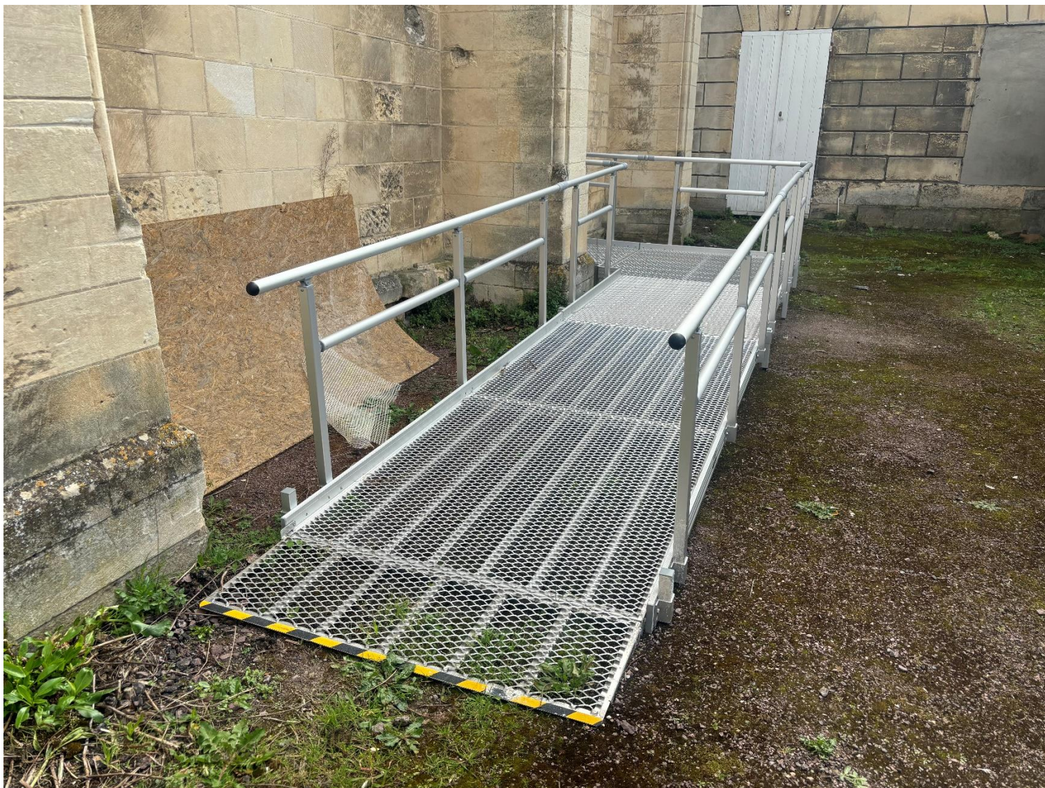
Eglise Sainte Trinité- Rampe d'accès PMR
