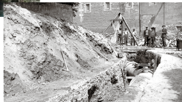
Rue Saint-Ouen, travaux d'assainissement dans les années 1930.
