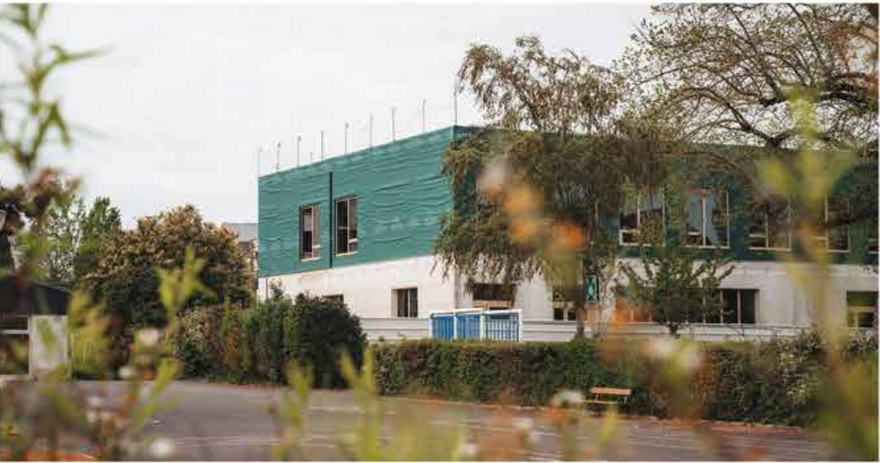
Travaux du futur Pôle enfance / jeunesse / associatif Puits Picard
